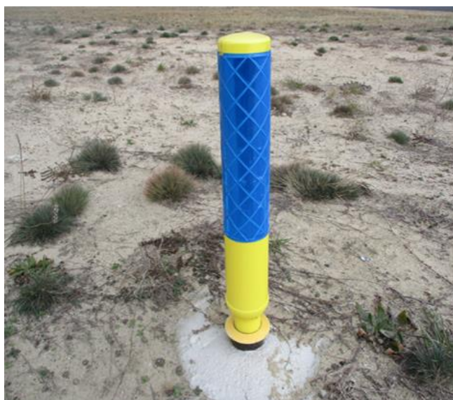
Fot. 8 Marker odblaskowy krawędzi drogi kołowania- barwa niebieska
